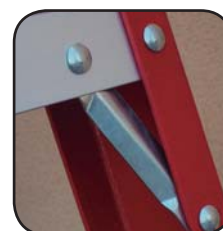
Detalle tirante refuerzo D tail renforcement Detalhe reforço
