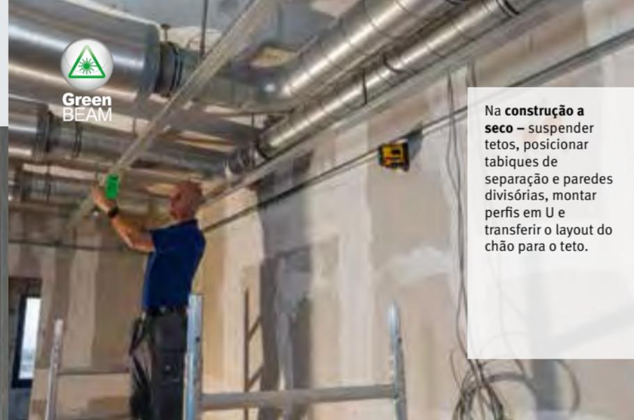
Na **construção a seco** – suspender tetos, posicionar tabiques de separação e paredes divisórias, montar perfis em U e transferir o layout do chão para o teto.
