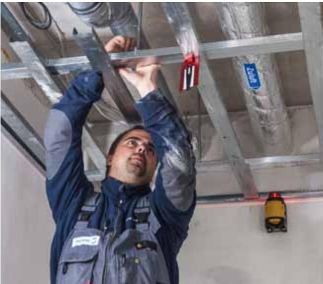
▲ Os perfis em U podem ser colocados e fixados numa só operação diretamente sobre a linha de laser visível.
